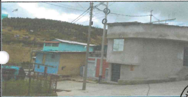
Vista lateral derecha del predio
